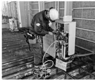
エアコン工事の風景
